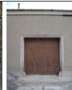
Detalle de fachada.
