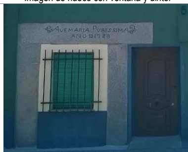
Imagen de hueco con ventana y dintel
