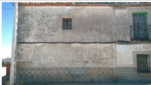
Detalle de acabados de fachada
