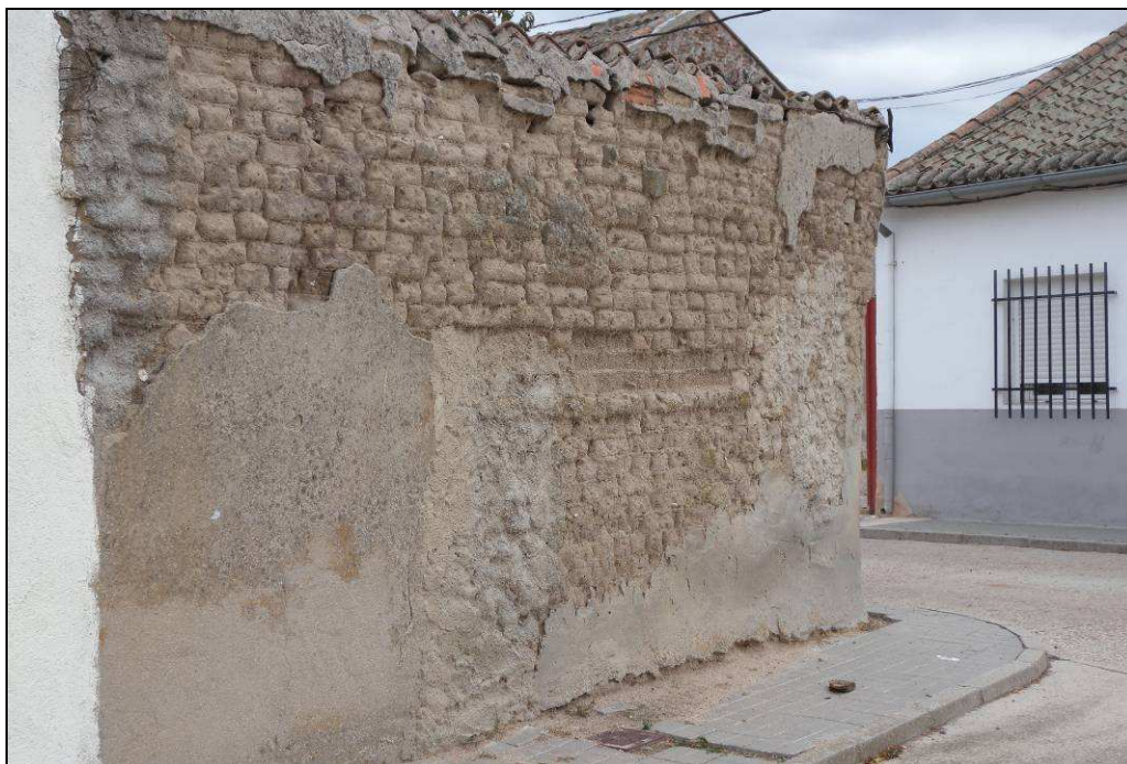
Uso tradicional del adobe en algunas construcciones del casco urbano.
