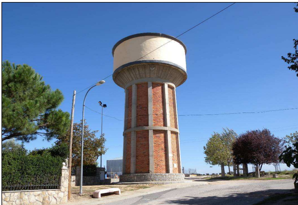
Depósito de agua de Muñopedro.
